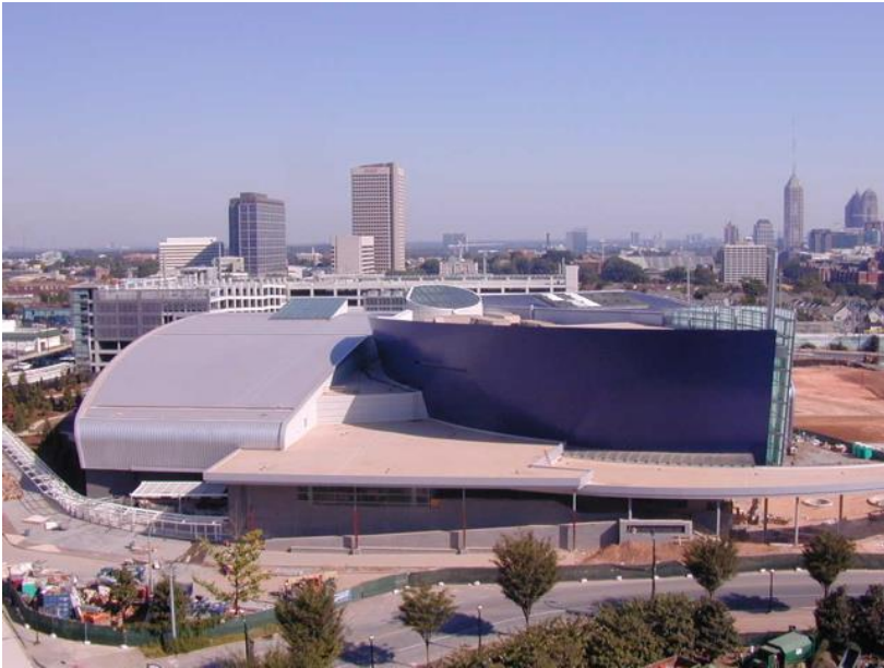
Acvariul „Georgia” – vedere exterioară.
