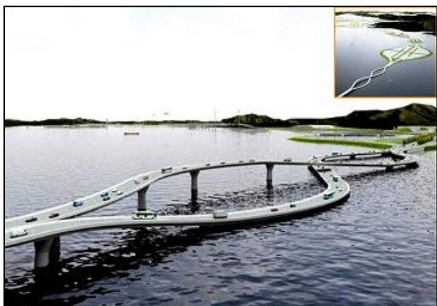
Figura 23 –Ponte invertida, que liga a China e Hong Kong compatibilizando o tráfego à esquerda que vigora em Hong Kong, com o tráfego à direita praticado na China.
